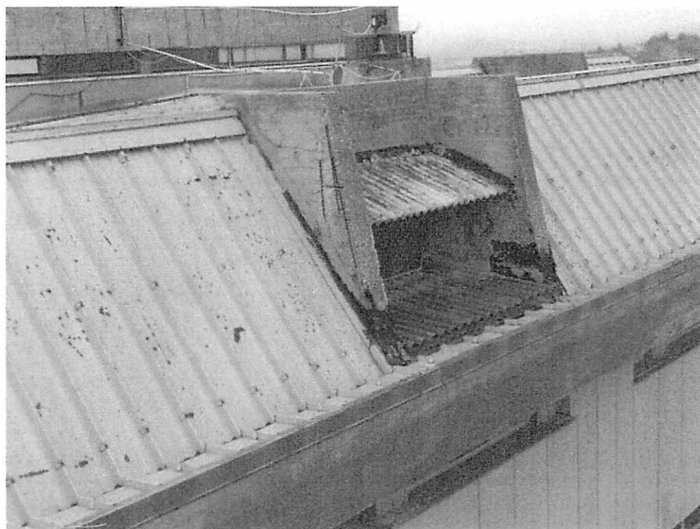
Foto intervento in copertura
