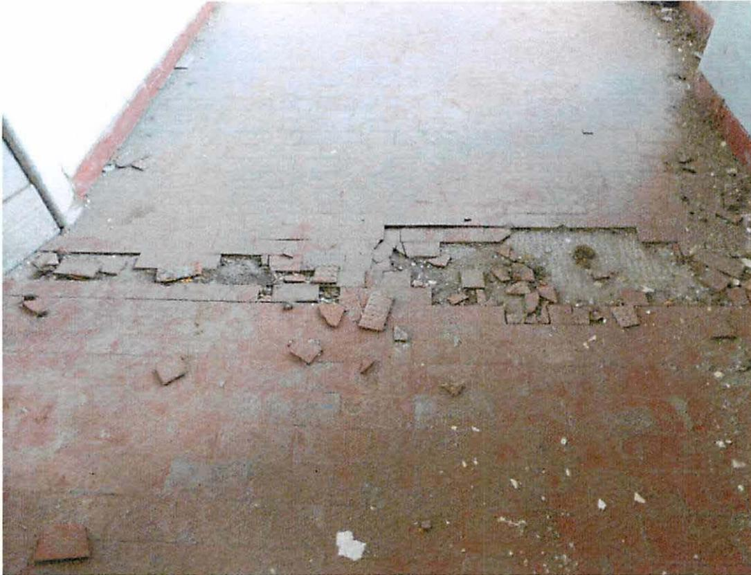
F15 - Lesione a pavimento\_corridoio di collegamento blocco A e C\_piano secondo
